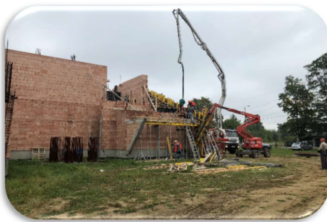
Budowa nowego kościoła
